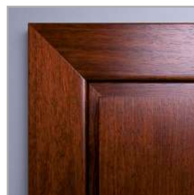
łączenie opasek pod kątem 45°
